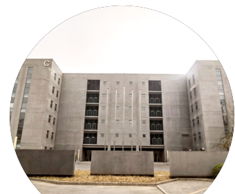
Site de production de Beijing, Chine
